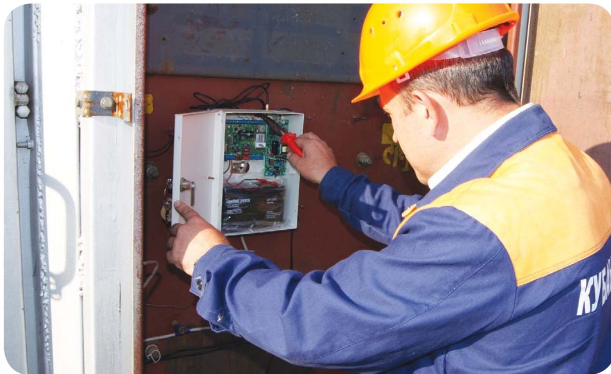
Монтаж GSM-сигнализации на объекте Тихорецких электрических сетей
