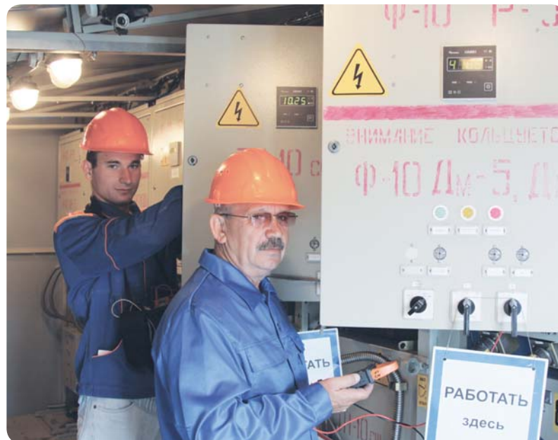
Специалисты группы по контролю качества электрической энергии службы метрологии и контроля качества электроэнергии Александр Ратиев и Алексей Пустовой производят замену приборов системы диспетчерского управления подстанции «Роговская»
