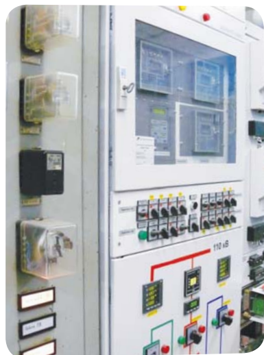
Микропроцессорное устройство для защиты силовых трансформаторов
