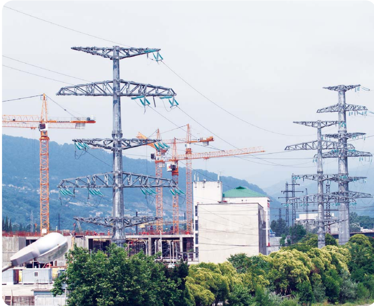
Конструкция опоры высотой 40 м рассчитана на ураганный ветер и подземные толчки до 9 баллов за счет прочного фундамента глубиной 10 м
