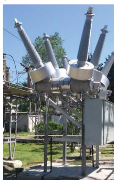
чинские энергетики продолжают вести работы в рамках реконструкции энергетического хозяйства. На подстанциях 110 кВ осуществляется постепенная реконструкция и капитальный ремонт. На одной из ключевых подстанций 110 кВ «Сочи» уже установлены новый трансформатор ТДТН-40000/110/10/6-У1 мощностью 40 МВА, элегазовый выключатель 110 кВ 145 РМ 40. На очереди – ячейки К61М и К-63. Все мероприя-
