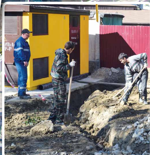
Носов Олег Владимирович, мастер Гиагинского РЭС Адыгейских электросетей и наемный персонал, выполняют работы по заводу кабельной линии 10 кВ
