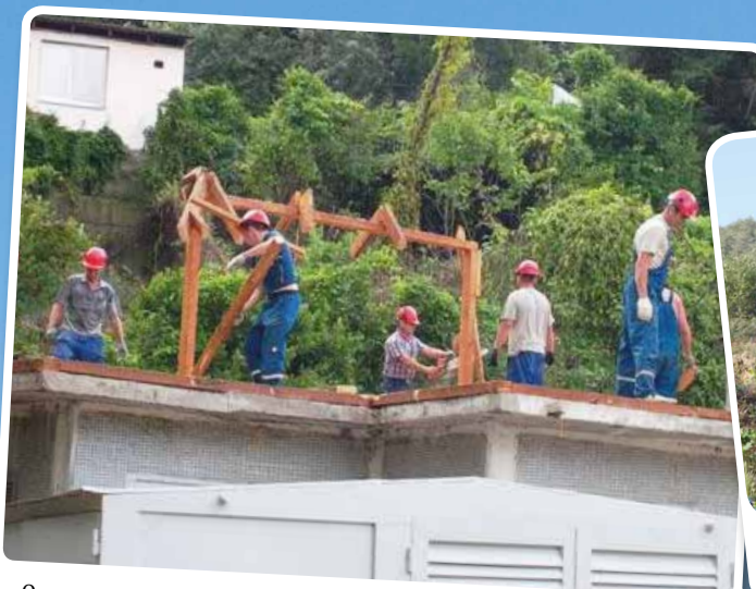
Один за всех и все за одного. Дружная сборная электромонтеров Ладожского, Братского, Березанского и Тбилисского сетевых участков выполняют демонтаж ЗТП
