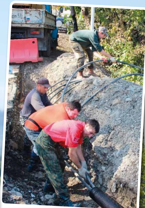
Тянем-потянем и проложим. Бригада кабельщиков Ленинградских электросетей на прокладке кабеля
